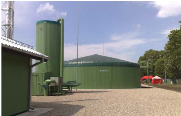
Fot. 1. Fermentator biogazowni wielosubstratowej (fot. A. Myczko)
