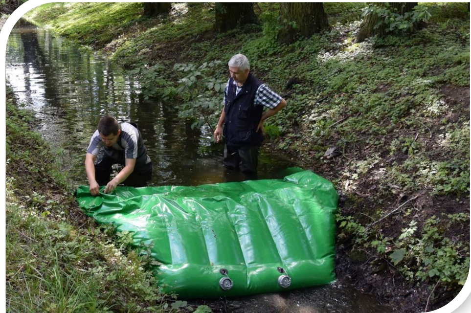
12. Zamykanie zaworu odpowietrzającego.
