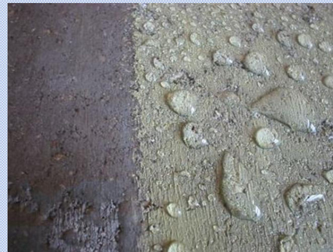
Ochrona powierzchniowa wykonana za pomocą powłoki ochronnej
