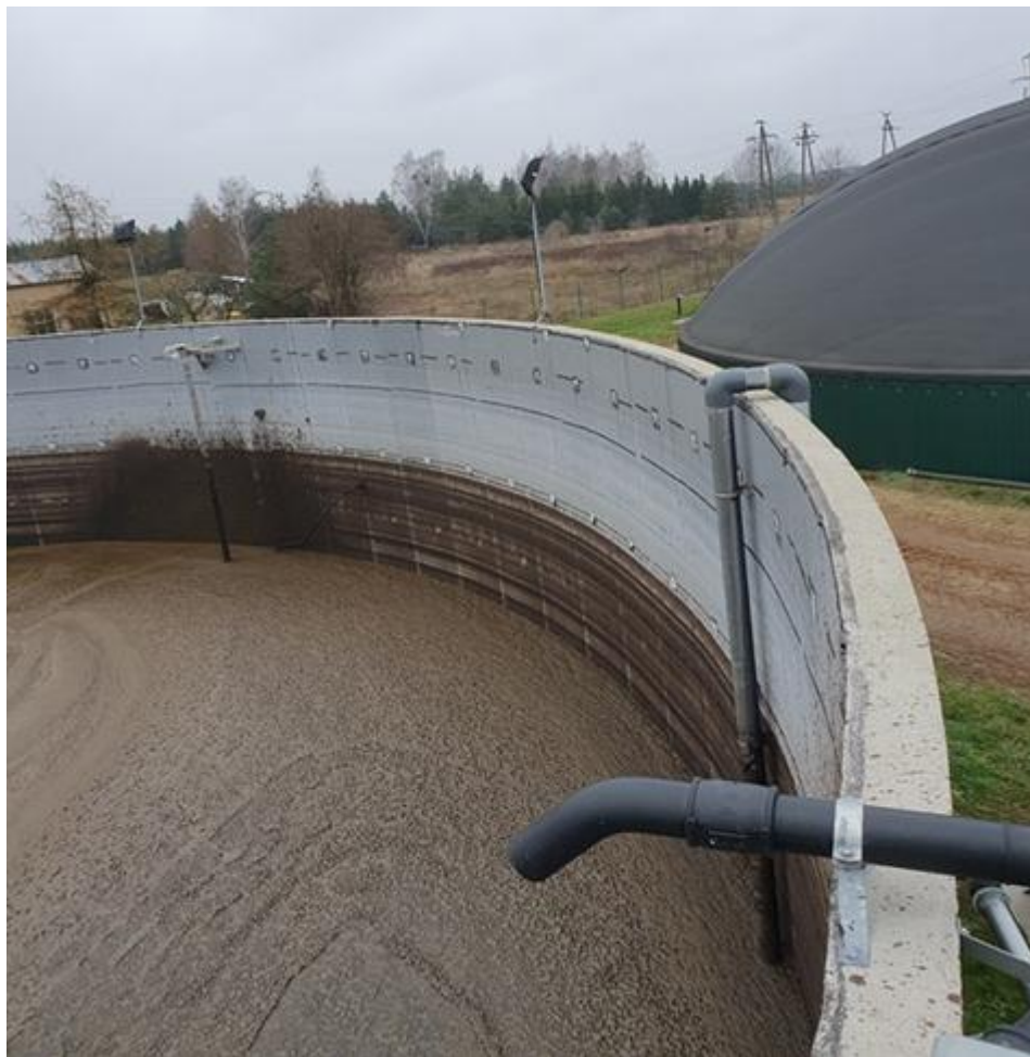
Rys. 2.2. Zbiornik na poferment w postaci ciekłej [zdjęcie własne]
